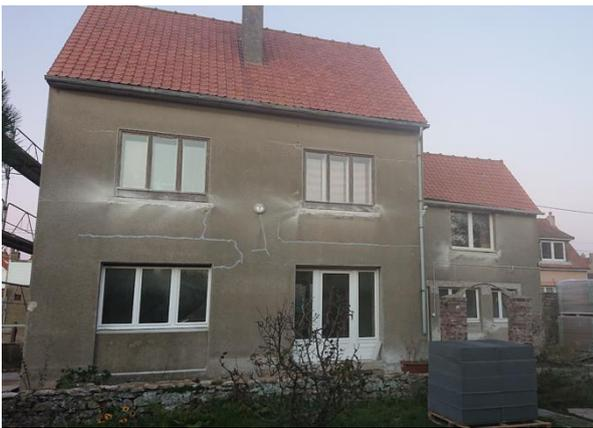
*Février 2018 : façade de béton dégradée, aucune isolation, fenêtres simple vitrage, pas de système de ventilation*
