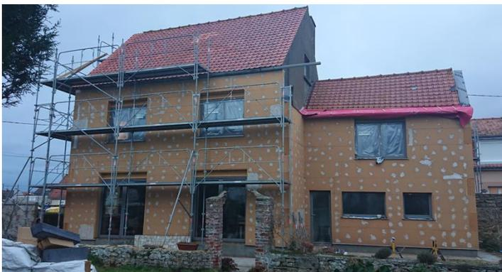
*Décembre 2018 : pose des menuiseries triple vitrage, pose des panneaux de fibre de bois ITE*
