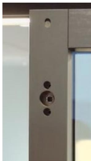
2. Positionner la platine rehausse devant les usinages du montant crémone du vantail motorisé, à l'aide de l'ergot de centrage.
